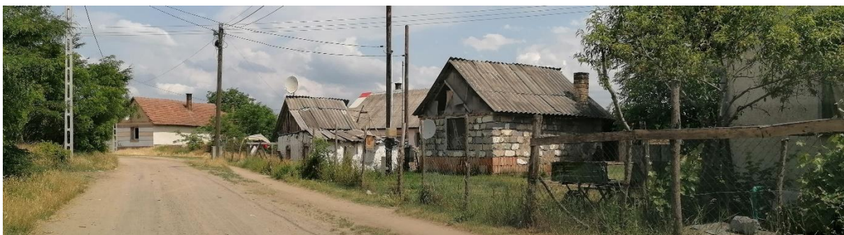
4. kép: A betonlapra épült "új" ház
