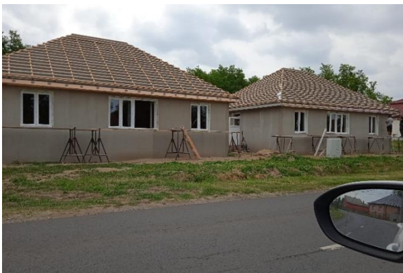
2. sz. kép Piricse – épülő Csillagházak a Bélteki utcán
