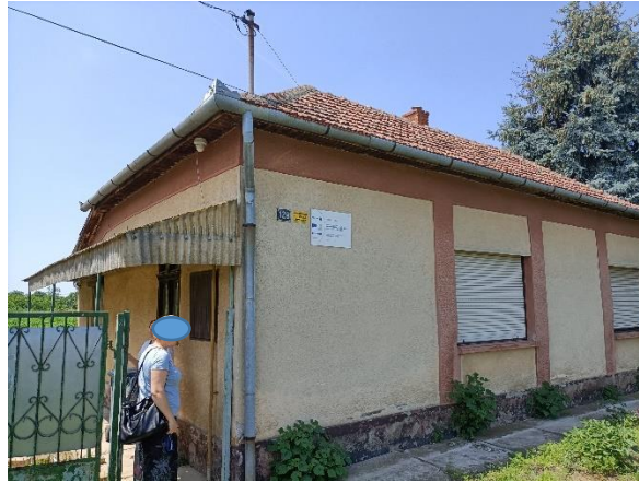
Jelenlegi Csillagpont épülete (forrás: saját kép)
