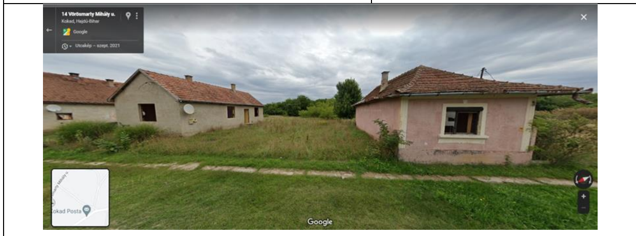
1 sz. kép - Ellopott tetőszerkezet, nyílászárók – Vörösmarty utca
