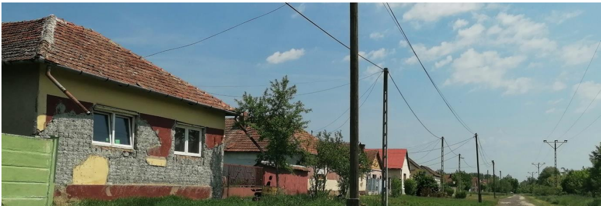
1. kép: Nyílászáró csere
